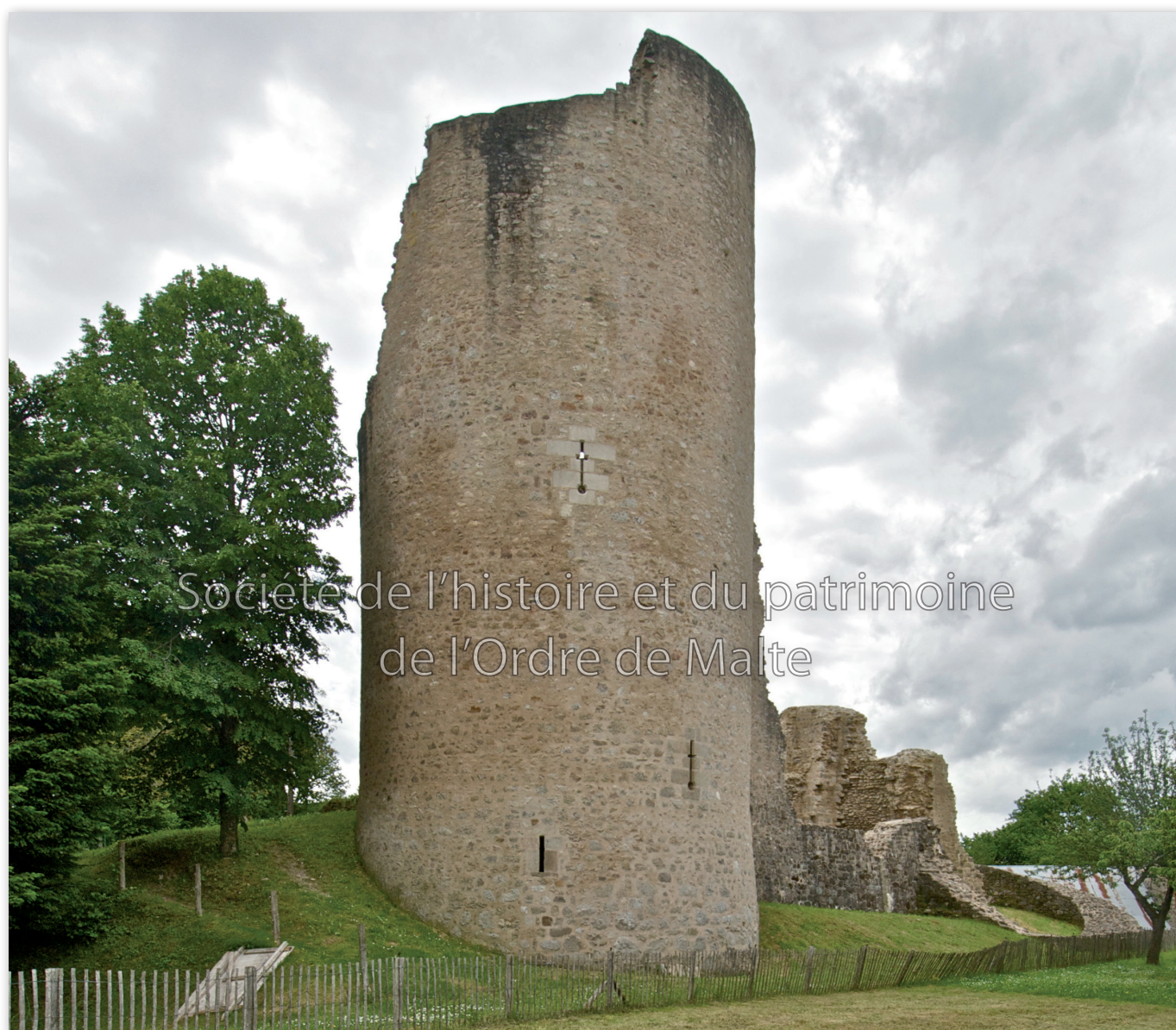
Fig. 1 - Le château du Monteil-au-Vicomte. La tour nord. Sur la droite de l'image, les restes de la base de la tour ouest (cl. JBV).
