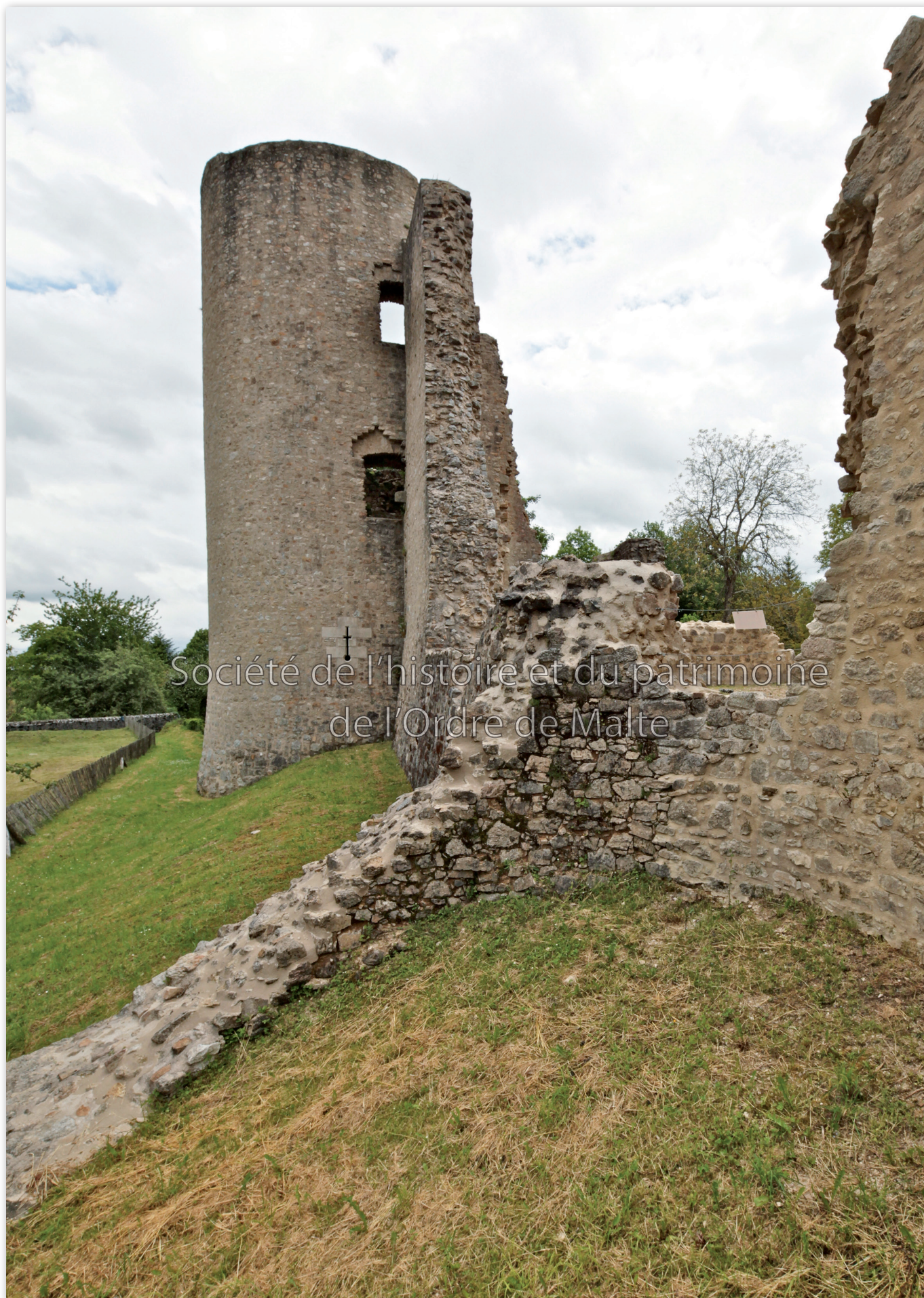
Fig. 2 - Vue prise de l'emplacement de la tour ouest : la tour nord, avec les traces des deux bretèches et une archère (cl. JBV).
