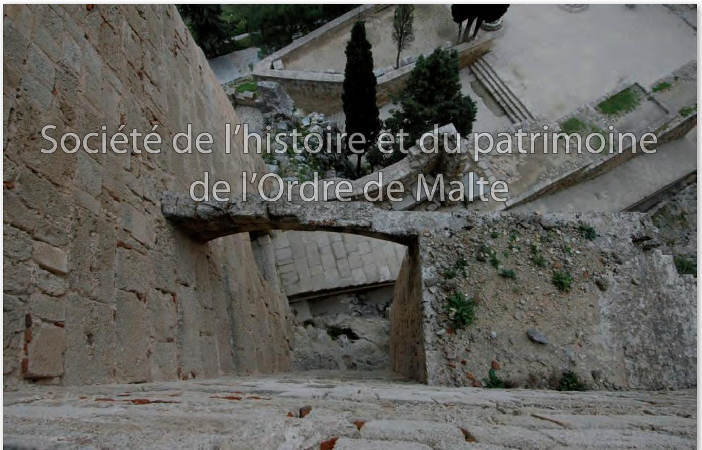
*Fig. 10 - Le palier supérieur de l'ancien escalier et l'arc-boutant subsistant. On distingue, presque contre le mur, l'emplacement de la porte primitive (cl. JBV).*
